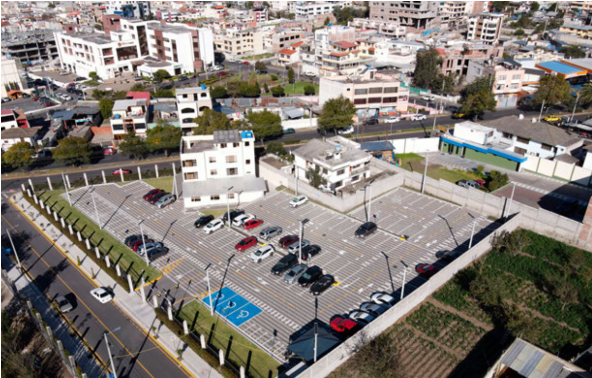
Figura 87 Construcción de Parquederos
